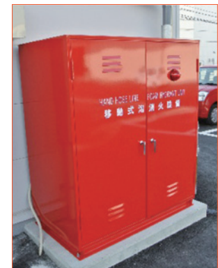
移動式泡消火設備
