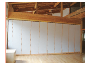
可動間仕切り
